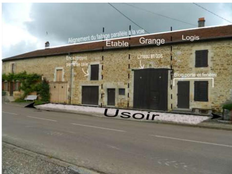
L'encadrement des fenêtres peut être orné de pierres de taille toujours apparentes (signe distinctif), onéreux à l'époque. Nous retrouvons des linteaux en bois ou en pierre pour les fenêtres et principalement en bois au dessus de la porte de la grange du fait de sa grande taille.
